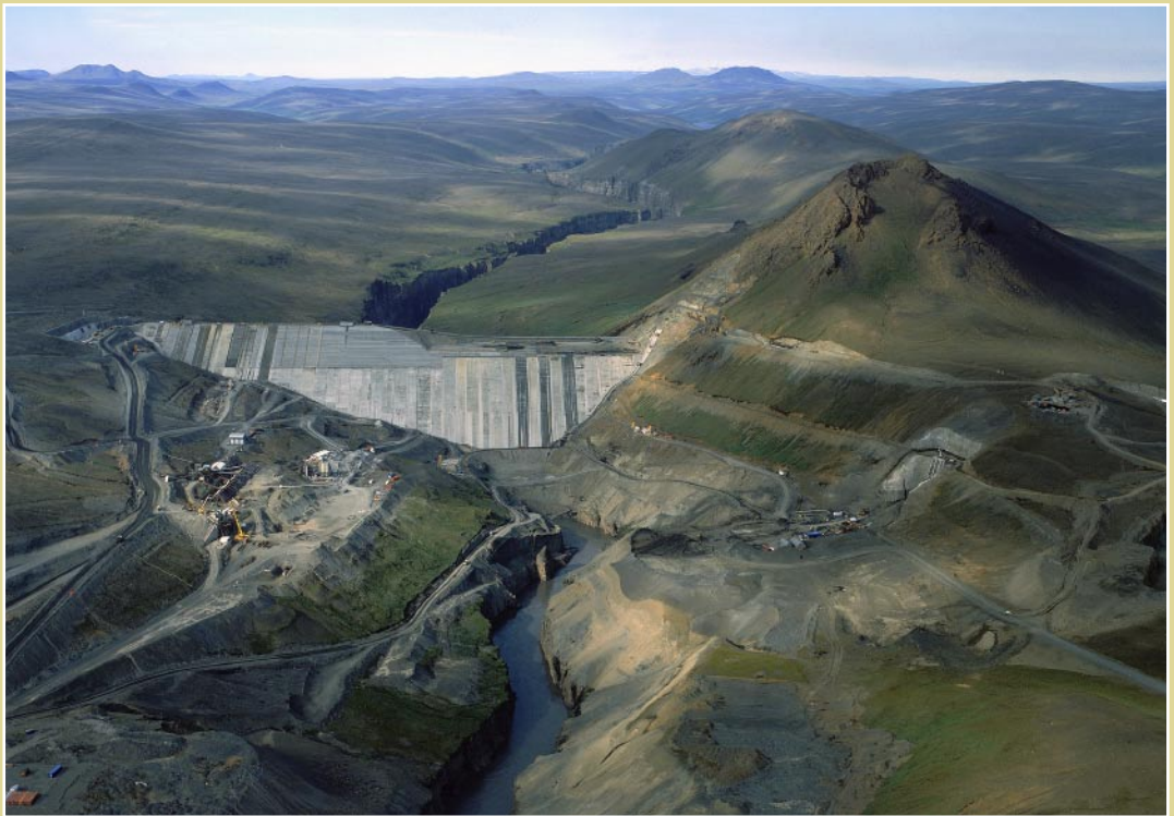
Kárahnjúkar vor und während dem Bau des Staudamms. © Haukur Snorrason, www.photos.is
